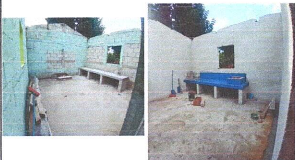
Foto 1: Reparación o sustitución de área de cocina. Creación de estufa rural y accesorios.
