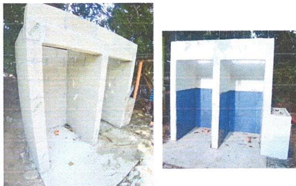
Foto 3: Mejoramiento y sustitución de servicios sanitarios y sus accesorios. Letrinas labables.
