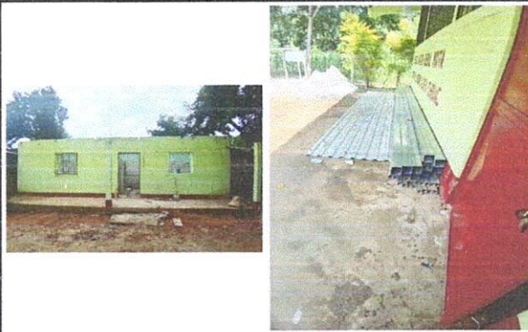
Foto 2: Reparación o sustitución de área de cocina. Sustitución de cubierta de techo y estructura metálica.
